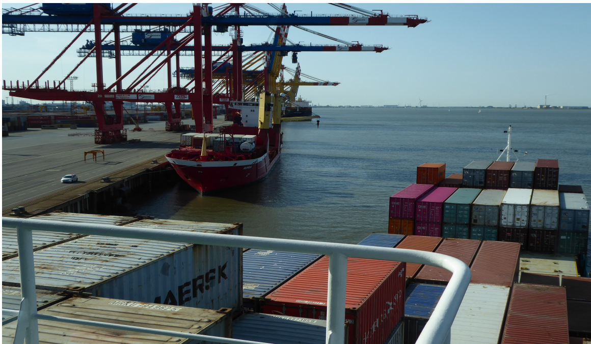
Containerpier an der Stromkaje in Bremerhaven
